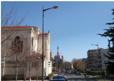
Réseau d'éclairage public : maintenance, enfouissement
