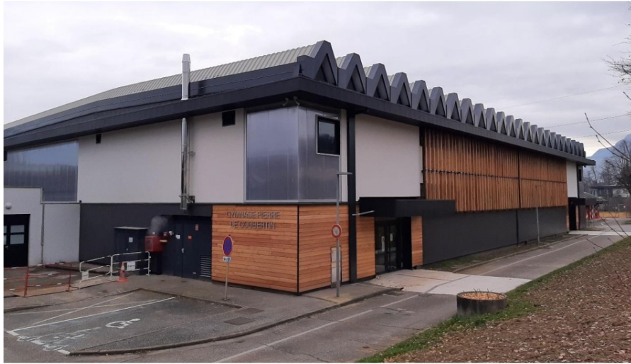
Gymnase Coubertin à La Motte Servolex Objectif de réduction des consommations énergétiques de 35%
