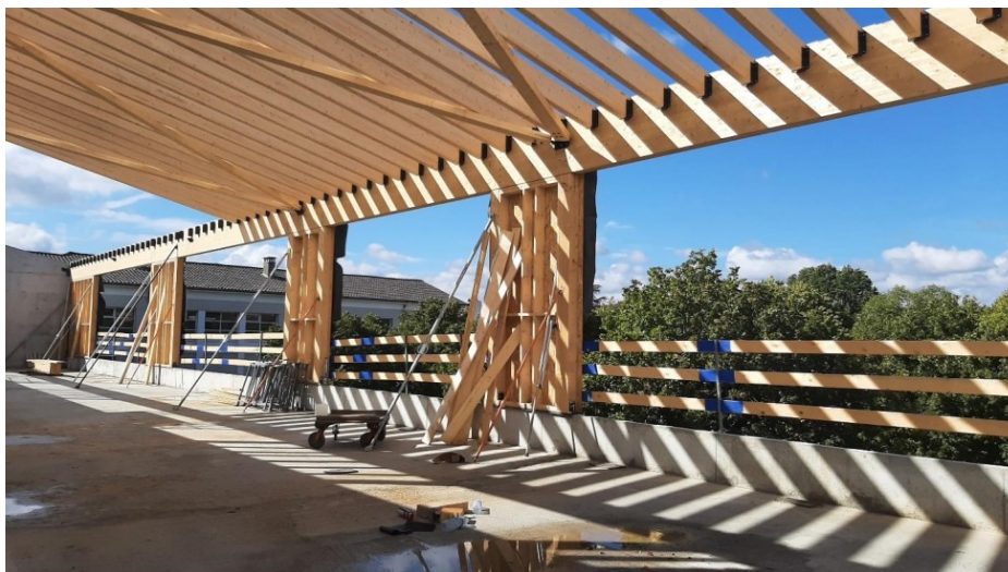
Ecole pasteur à Grigny - Reconstruction de l'aile centrale - Objectif de réduction des consommations énergétiques de 50% , compris l'accroissement de surface
