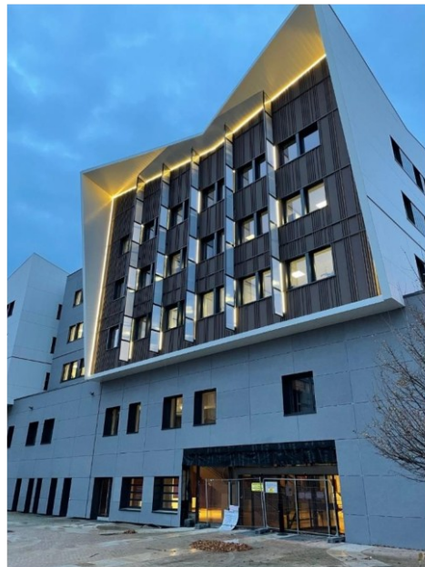
Bâtiment administratif Paul Pillet à Roanne Objectif de réduction des consommations énergétiques de 53,4%
