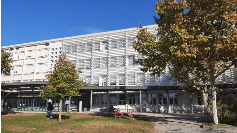
Lycée Albert Triboulet à Romans-sur-Isère pour la Région Auvergne-Rhône-Alpes Objectif de réduction des consommations énergétiques de 41,2 %
