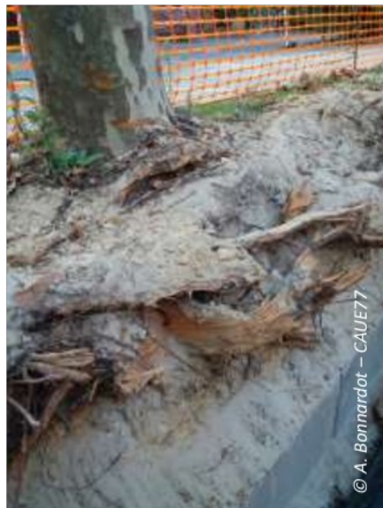
Racines de platane détériorée lors de l'ouverture d'une tranchée.
