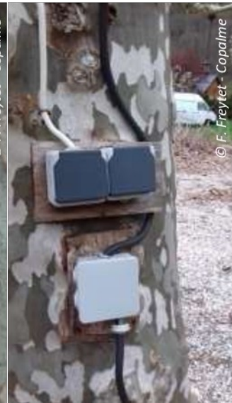
Installations électriques sur platane.
